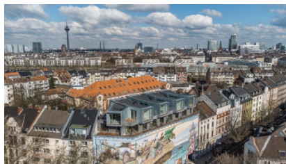
Bildzeile: Bilker Bunker Drohnenansicht © Bilker Bunker / Wolfgang Flamisch
